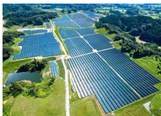
リエネ長南太陽光発電所 (千葉県長南町)
